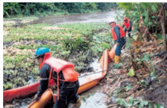
OLEODUCTO. Siguen las obras de remediación ambiental.
