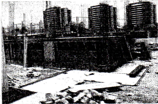
Construyeron sin licencia y sin Estudio de Impacto Ambiental
